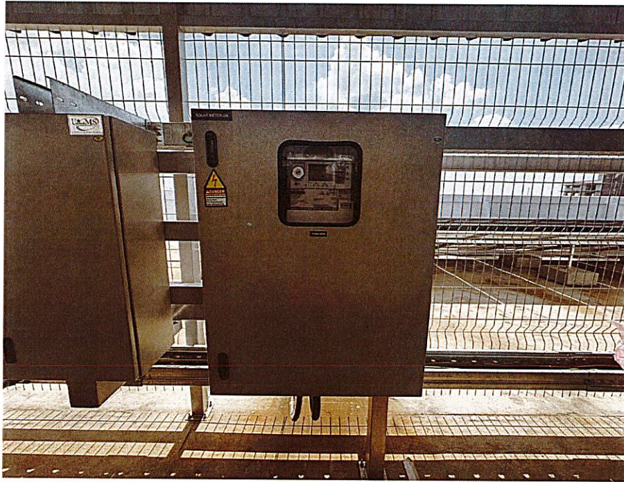
งานติดตั้งระบบกราวด์
